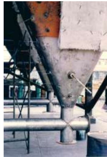
FABRICACION Y MONTAJE DE FILTRO DE PURGA PARA INDUSTRIAS NEGROMEX EN SALAMANCA, GTO.
