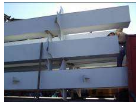
Fabricación de columnas a base de 4 placas para Procter & Gamble Proyecto “LAGER”
