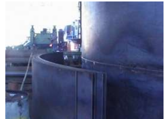
ROLADO Y CONFORMADO DE PLACAS DE ANILLOS
