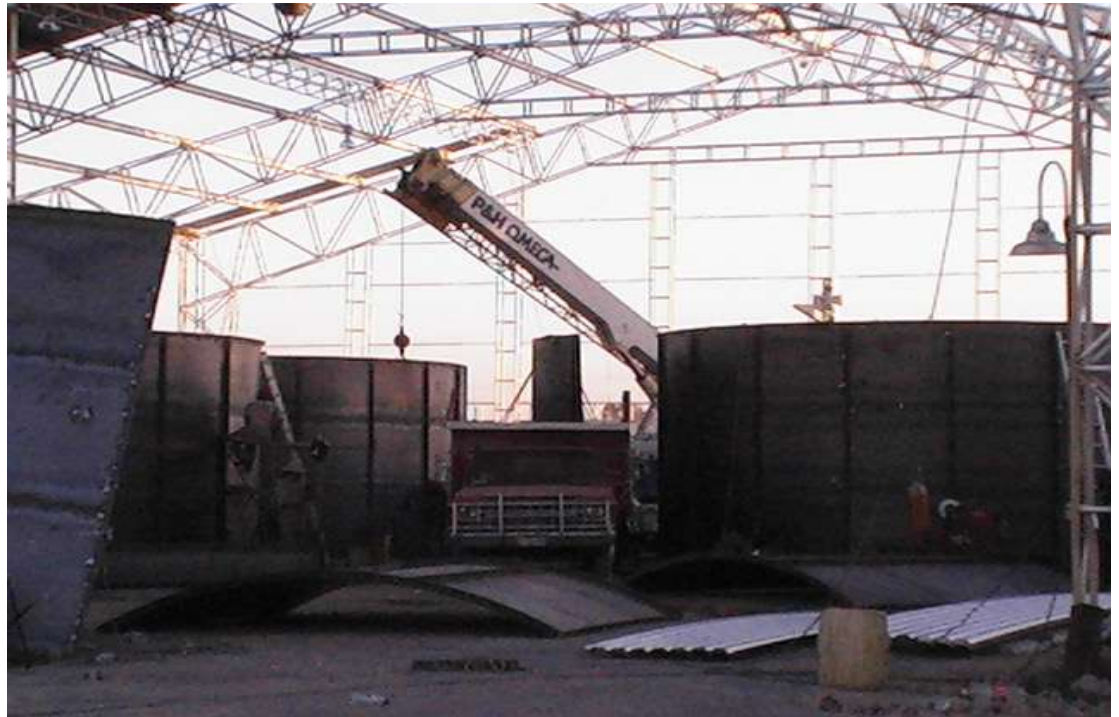
ARMADO DE ANILLOS DE SILOS EN TALLER
