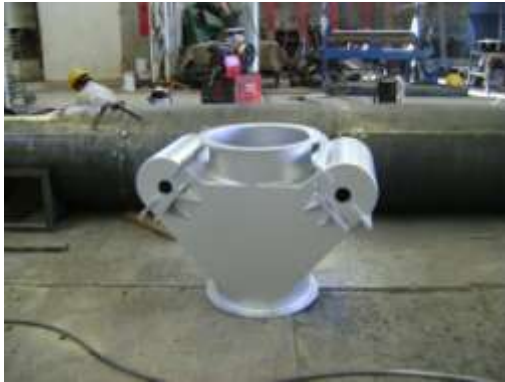
Fabricación de compuertas
