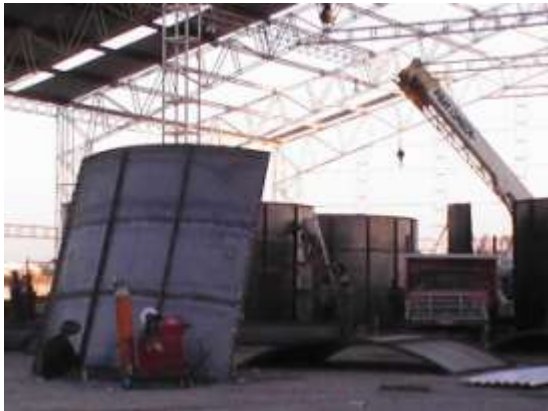
ARMADO DE ANILLOS DE SILOS EN TALLER
