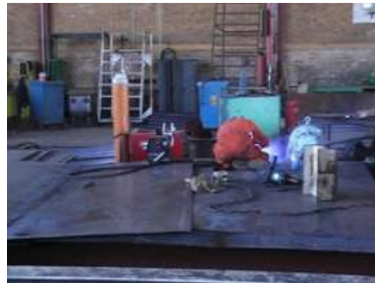
SOLDADURA EN PLACAS DE ANILLOS
